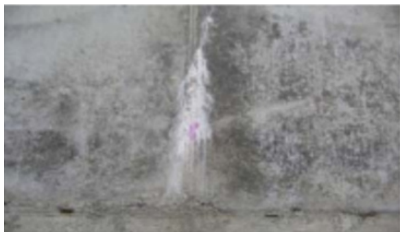
Сурет 2 – Жертөле қабырғасының тік бетінде бетонның тығыздалмауы аймағында жоғары түзілуі
