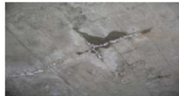
Сурет 1 – Жертөле қабатының монолитті аражабын тактасы. Судың шөгу жарықтары арқылы сүзілуінен пайда болған қара дақтар
